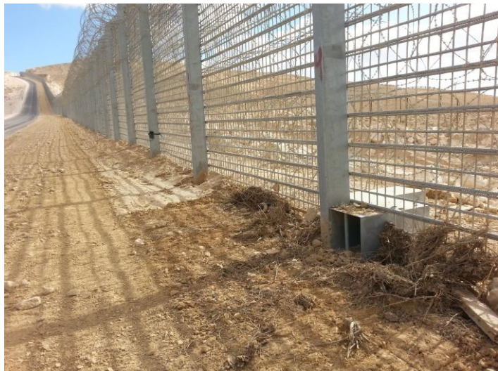
איור 33 - תמונה מספר 27ב'. מעבר ל' הממוקם מתחת לגדר הגבול עם מצרים. מאפשר מעבר של יונקים קטנים ובינוניים. הגדר התלתלית, מעברו
