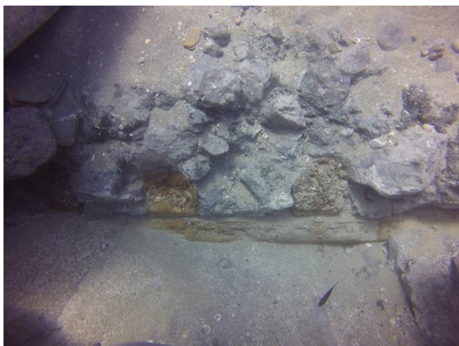
איור 9 (מימין): מבט על שטח החפירה בראש שובר הגלים המערבי. החפירה מתנהלת בתוך תבנית מתכת ובאמצעות דרג'ר תת-ימי; איור 10 (משמאל): חלקי העץ: צלעות עגולות ולוחות דופן של תבנית הרודיאנית ששימשה נדבך יסוד לשובר הגלים המערבי. בתוך התבנית ניתן להבחין בקונגלומרט של אבנים בינוניות ובמלט מסוג פוצלנה (אפר וולקני שהגיע מפוטיאולי, איטליה).
