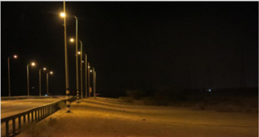
תאורה בצומת סמר, כביש 90 - לפני החלפת התאורה. מרחק ההארה האחורי לפני החלפת התאורה גדול מ 50 מ'. צילום: אלכס גולדין
