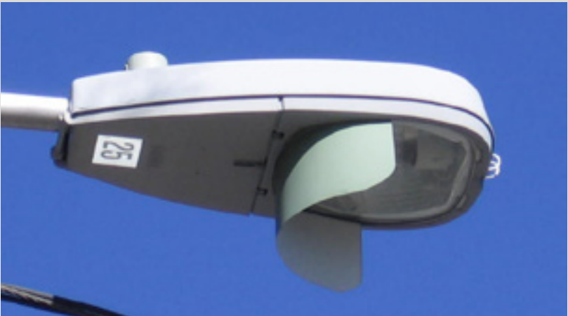
דוגמא למסתיר אור אחורי מכאני אשר אינו מקורי של יצרן גוף התאורה, המותקן לאחר התקנת עמוד התאורה | צילום: John Murden
