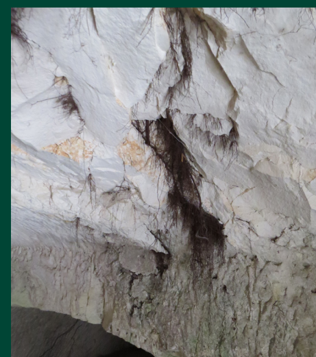
מערה 26. התפוררות וקריסה של קירות בשל חדירת שורשי עצים במערת "ראש בית הכנסת הצידוני".
