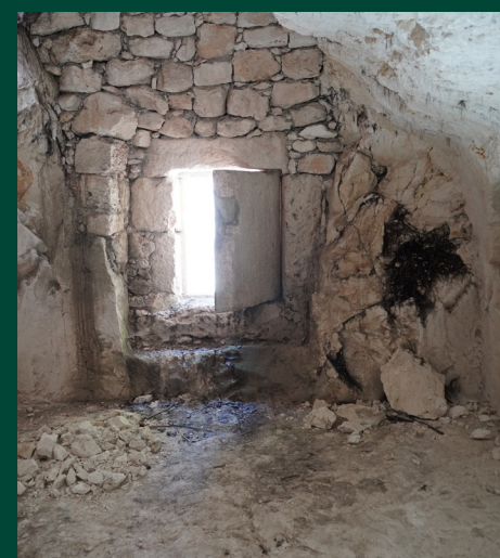
מערה 25. מבט מבפנים על קריסה של קירות המערה בעקבות חדירת השורשים.
